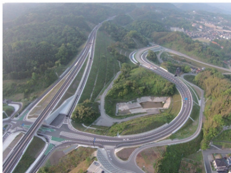
山陰道浜田港インターチェンジ
